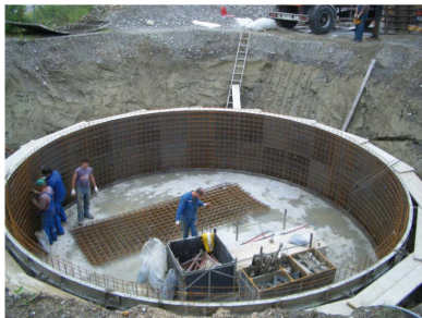
Eisspeicher im Bau, Fa. Isocal
