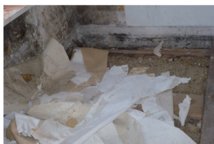
Geschossdecke Oberge- schoss „Terrassenhaus“
