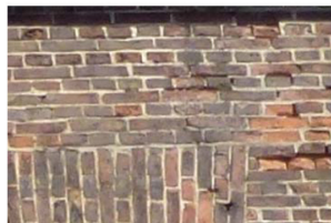
Detailaufnahme Mauerwerk „Valentinahaus“
