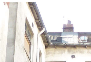
Dach Rückseite „Jupihaus“
