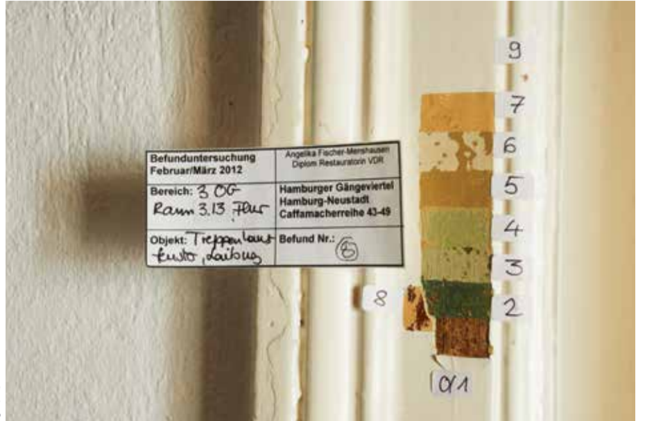
Freigelegte Farbschichten im Kupferdiebehaus – Foto: Franziska Holz, 2013
